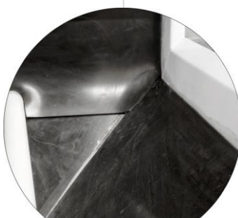
Vnitřní prostory bez lemů pro rychlé čištění
