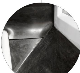
Vnitřní prostory bez lemů pro rychlé čištění
